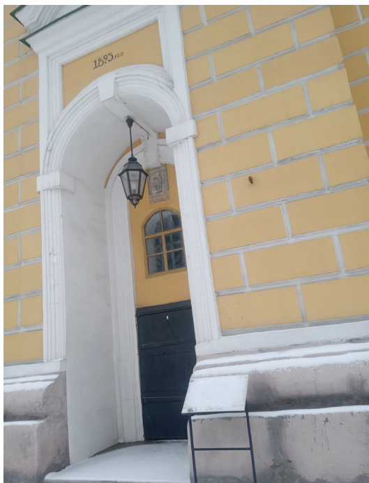
Рис. 6. Сучасний вигляд північного фасаду Великої Лаврської дзвіниці (1731–1744) із входом у «комірку» — одне з приміщень колишнього Синодального архіву. Фото: О. Черняхівська
